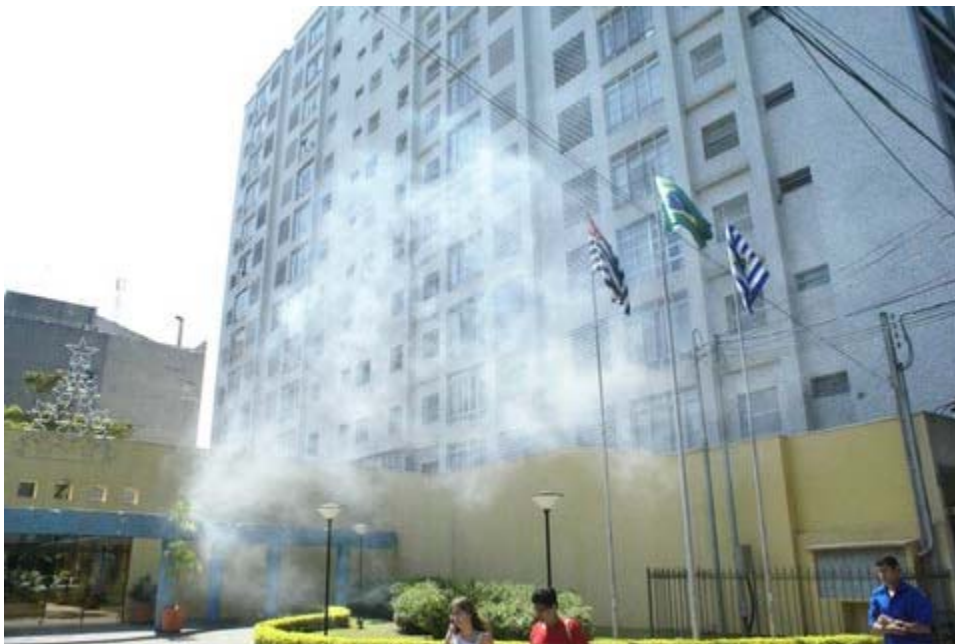
Fumaça saindo do apartamento no 3º pavimento
